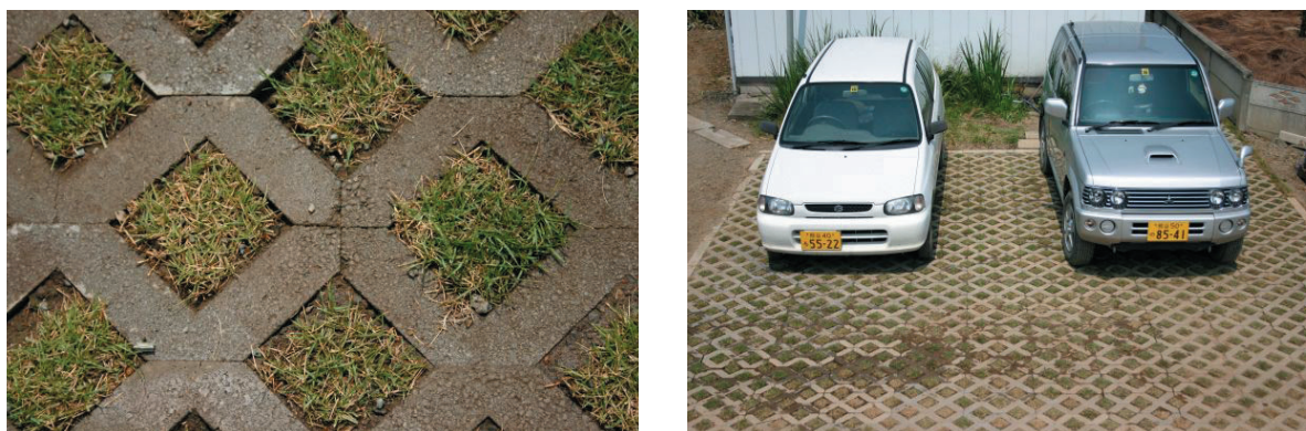
タマコン施工完成後、芝を貼った敷設実験（18.7.18）
